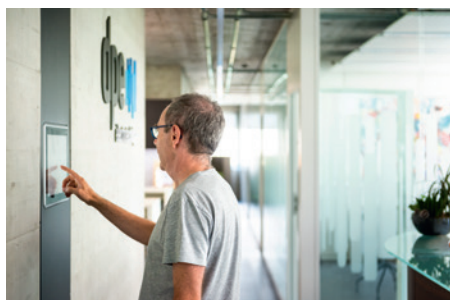
Le bâtiment est connecté.
